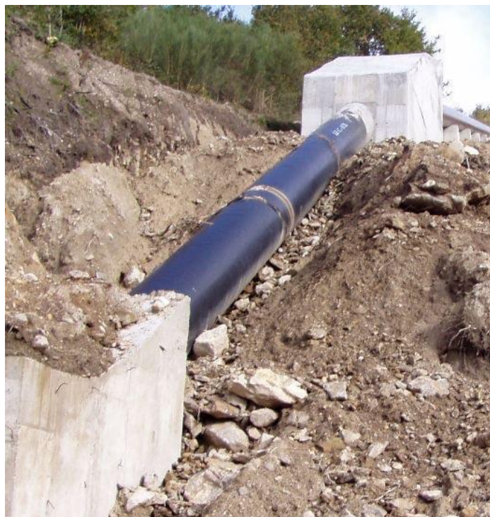
Foto 3-13. Bloques de anclaje en concreto reforzado en tubería aérea
